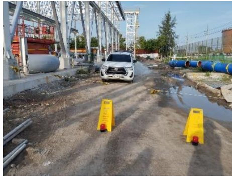
รูปที่ ค-71 กันเขตพื้นที่ก่อสร้าง พร้อมติดป้ายสัญญาณเตือนแสดงเขตหวงห้ามที่อาจเกิดอันตราย
