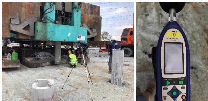
รูปที่ ค-16 ควบคุมระดับเสียงจากกิจกรรมของโครงการไม่ให้มีค่าเกิน 85 เดซิเบลเอ
