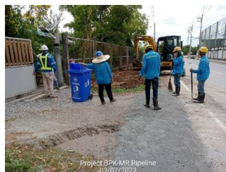
รูปที่ ค-3 ดำเนินการฝังกลบหน้าดินและคืนพื้นที่ หลังจากวางท่อแล้วเสร็จ
