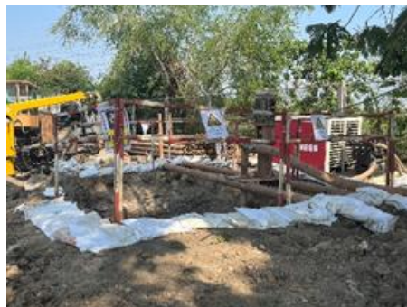
รูปที่ ค-21 โครงการมีการกั้นพื้นที่โดยการจัดวางถุงทรายขณะมีการก่อสร้างบ่อรับ-บ่อส่ง
