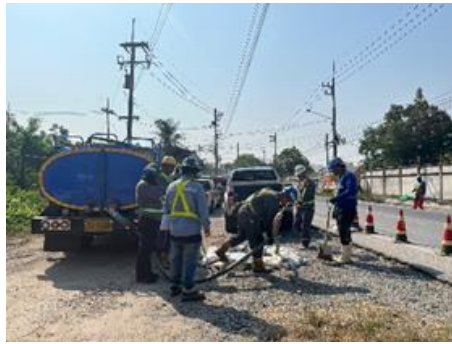
รูปที่ ค-23 โครงการมีการซ่อมแซมถนนผิวจราจรโคลนโซเดียมเบนโทไนท์รั่วไหล
