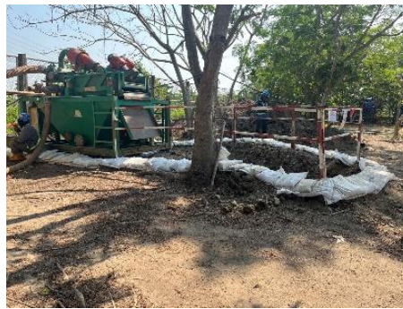
รูปที่ ค-20 โครงการมีการวางถุงทรายหรือจัดทำคันดินกั้นรอบพื้นที่ เพื่อป้องกันการพังทลายของดินลงสู่คลองขุดโก่งกวาง
