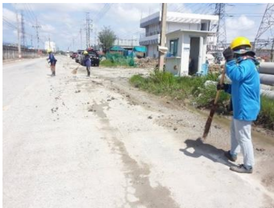
รูปที่ ค-6 ทำความสะอาดพื้นถนน หากพบว่าวัสดุก่อสร้างหรือดินตกหล่นบนถนน
