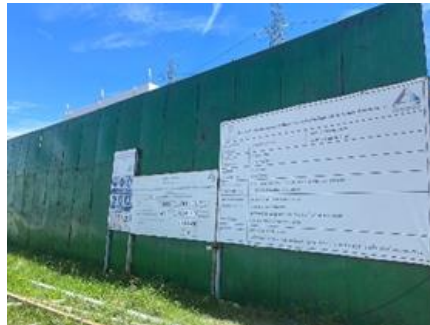
รูปที่ ค-37 ติดตั้งรั้วเหล็กหรือกำแพงคอนกรีต กันโดยรอบพื้นที่ก่อสร้าง
