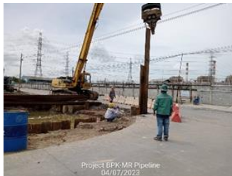
รูปที่ ค-72 ตรวจสอบไม่พบสิ่งกีดขวางหรือผู้ปฏิบัติงานที่อยู่ในระยะที่อาจเกิดอันตรายจากการยกท่อลงร่องขุด
