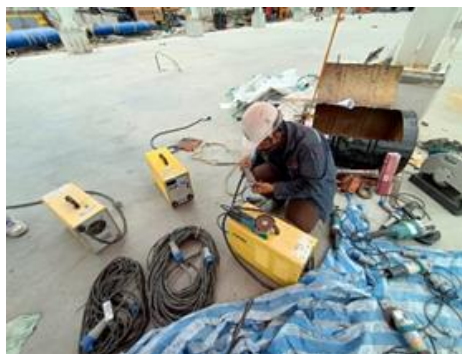
รูปที่ ค-73 ตรวจสอบสภาพเครื่องเชื่อมท่อก๊าซให้อยู่ในสภาพพร้อมใช้งาน
