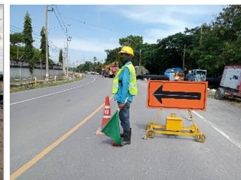
รูปที่ ค-42 อำนวยความสะดวกด้านการจราจรบริเวณพื้นที่ก่อสร้าง
