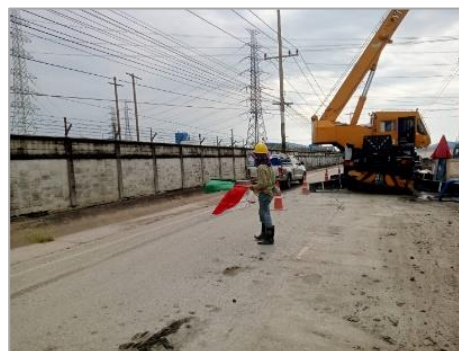
รูปที่ ค-42 อำนวยความสะดวกด้านการจราจรบริเวณพื้นที่ก่อสร้าง
