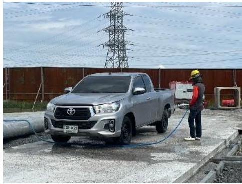
รูปที่ ค-7 ทำความสะอาดล้อรถ ก่อนออกจากพื้นที่โครงการ
