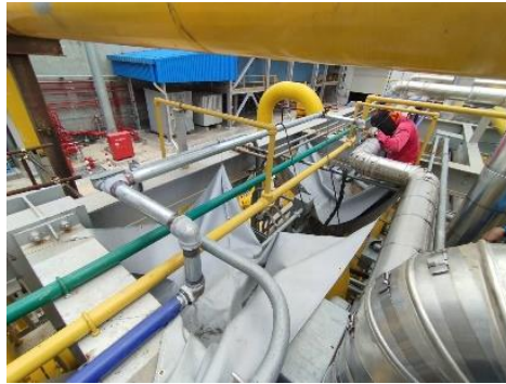
รูปที่ ค-76 จำกัดเขต และระมัดระวังเศษโลหะหรือประกายไฟบริเวณพื้นที่ทำงานเชื่อมต่อ
