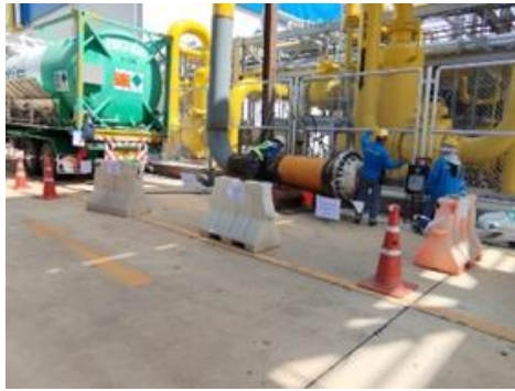
รูปที่ ค-71 กันเขตพื้นที่ก่อสร้าง พร้อมติดป้ายสัญญาณเตือนแสดงเขตหวงห้ามที่อาจเกิดอันตราย
