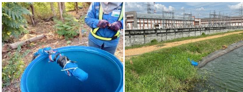
รูปที่ ค-30 ควบคุมอัตราการระบายน้ำออกจากท่อส่งก๊าซธรรมชาติ ภายหลังการทดสอบการรั่วไหลของท่อด้วยวิธีทางชลสถิติ
