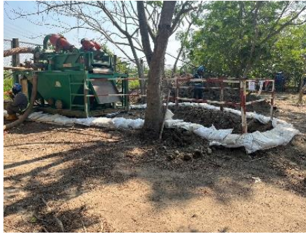
รูปที่ ค-51 จัดวางถุงทรายหรือทำคันดินกั้นรอบพื้นที่และบริเวณที่มีการหลั่นหรือรื้อไหล
