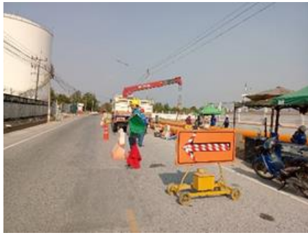
รูปที่ ค-39 จัดพื้นที่จอดรถขนส่งวัสดุและต้องจัดวางเครื่องจักร อุปกรณ์ และวัสดุก่อสร้างให้เป็นระเบียบ
