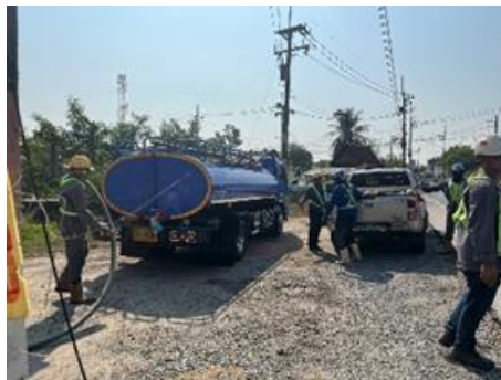
รูปที่ ค-53 ใช้รถดูดในการเก็บเศษดินหรือโคลนโซเดียมเบนโทไนท์ในบ่อรับ-บ่อส่ง
